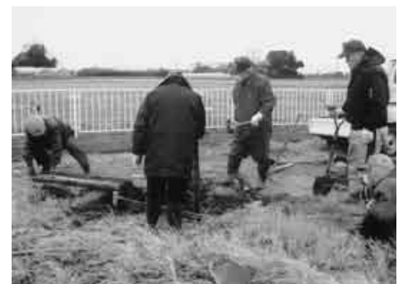
農道の隔切り補修
